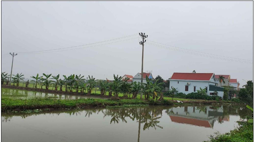
ĐƯỜNG ĐIỆN 22/0.4KV TRONG KHU VỰC QUY HOẠCH
